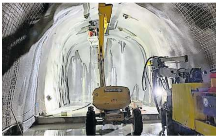
Die Bauarbeiten in Sachseln sind vorerst abgeschlossen. Bild: PD
